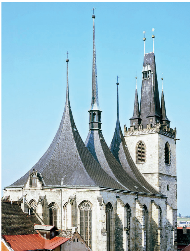
Kościół pw. Św. Michała w Louny w Czechach ( www.historickasidla.cz )
